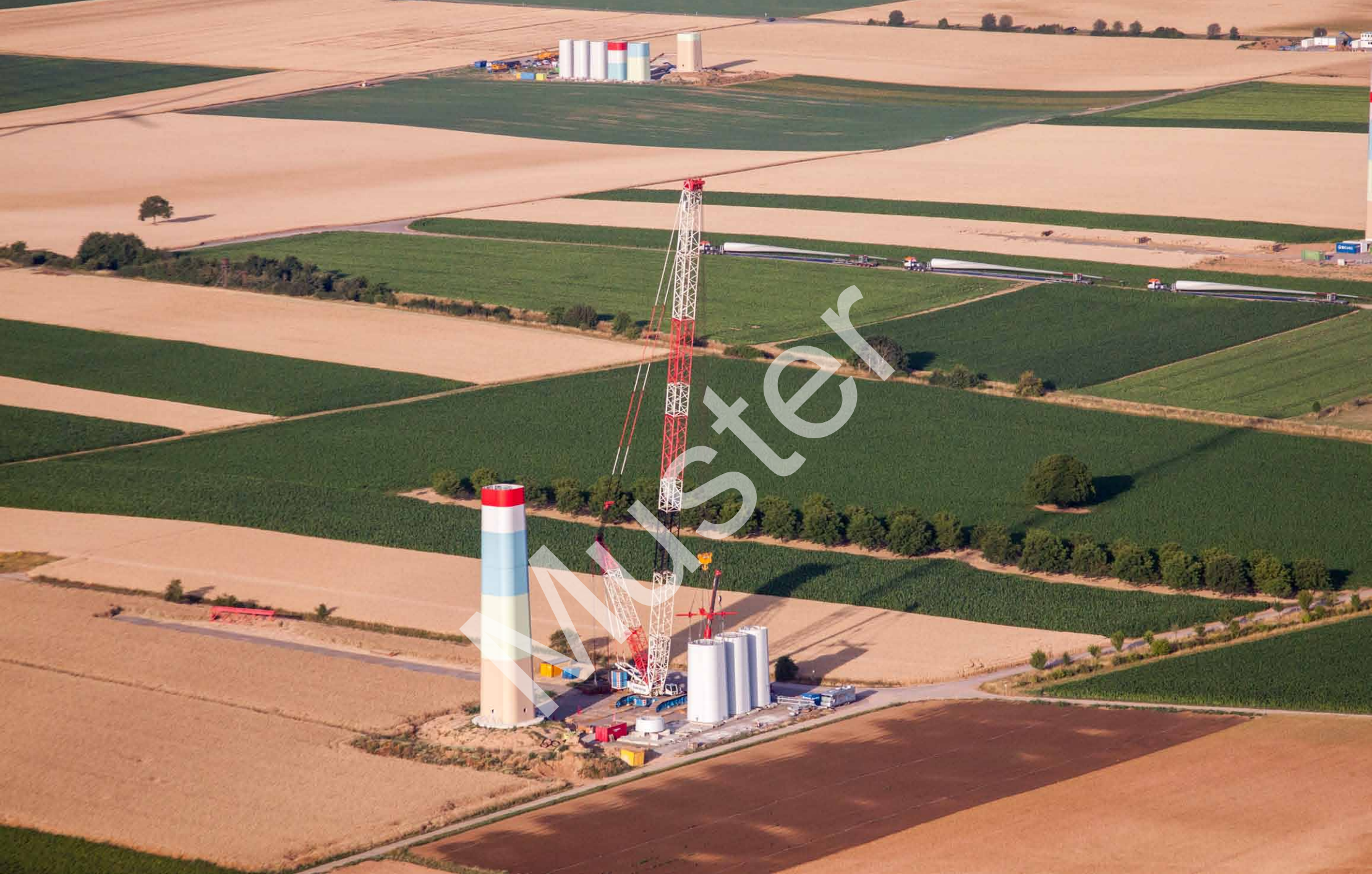
Windparkbaustelle bei Offenbach an der Queich
