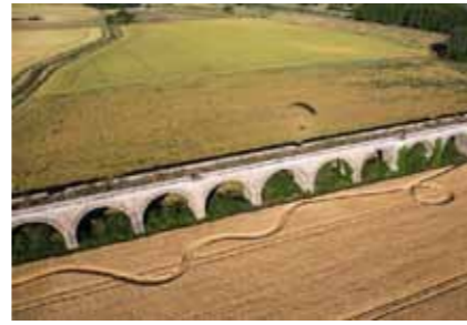
Juli Viadukt bei Vineuil (F-Loire) 20. Juni 2015
