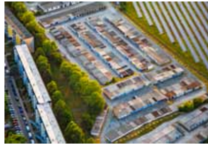
Februar Garagenhöfe in Blankenburg (Harz)
